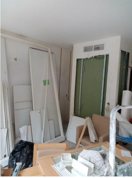
Les cloisons et la gaine technique ont dû être démontées dans cet appartement où les chiens persistaient à signaler la présence des punaises
